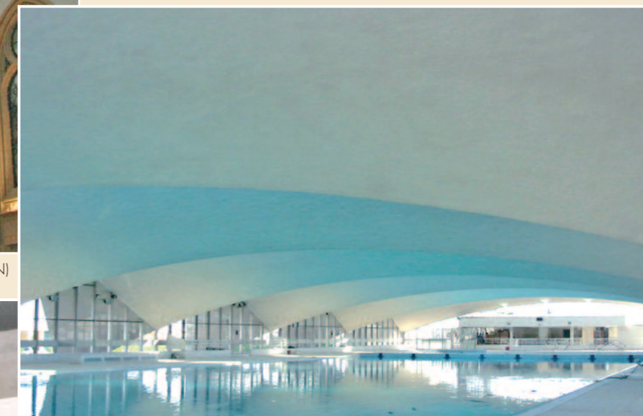
Piscine Deauville (Ste SONISOL - 44 470 CARQUEFOU)
